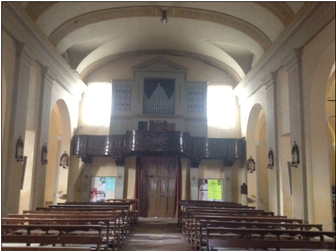
foto 7 – vista della navata centrale, verso la parete di controfacciata; si nota la copertura ad arco ribassato con lunette cieche
