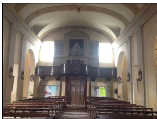
foto 16 - finestre con strombatura sulla controfacciata
