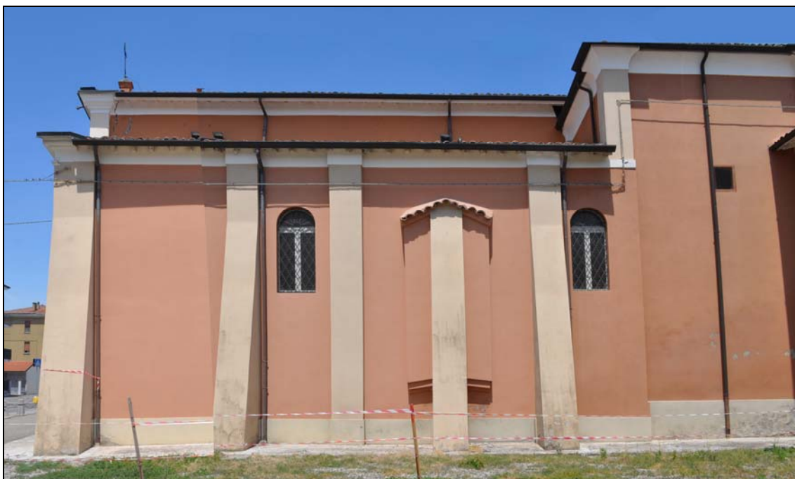
foto 3 – fianco sinistro (rivolto a Sud): in evidenza i quattro “speroni” che fungono da contrafforti e la parasta centrale
