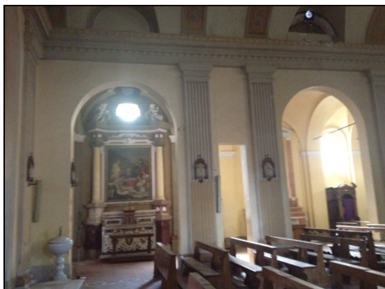
foto 15 - grandi aperture nelle pareti laterali della navata
