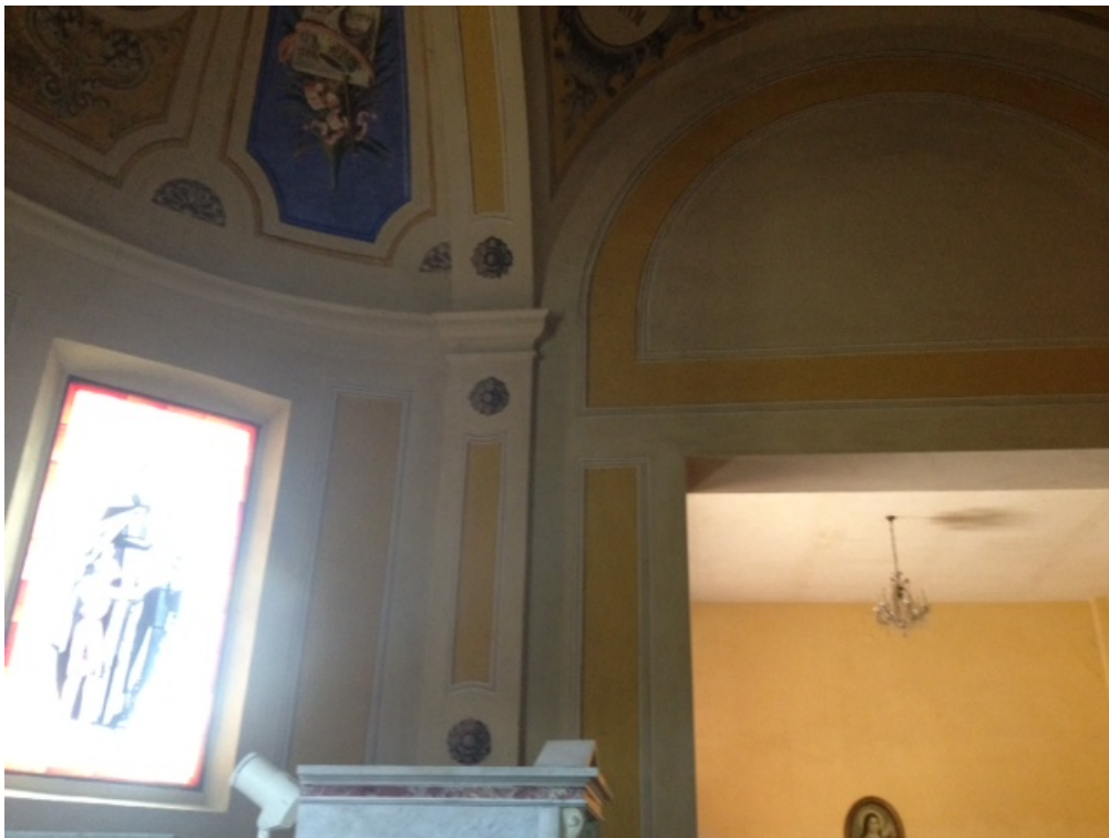
FOTO 14 - particolare dell'innesto abside - transetto
