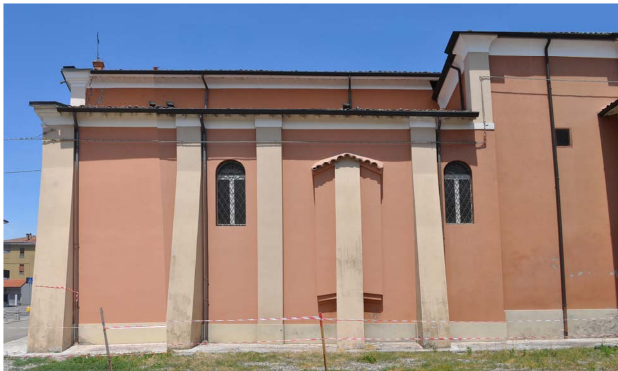
FOTO 3 - vista del fianco sud
