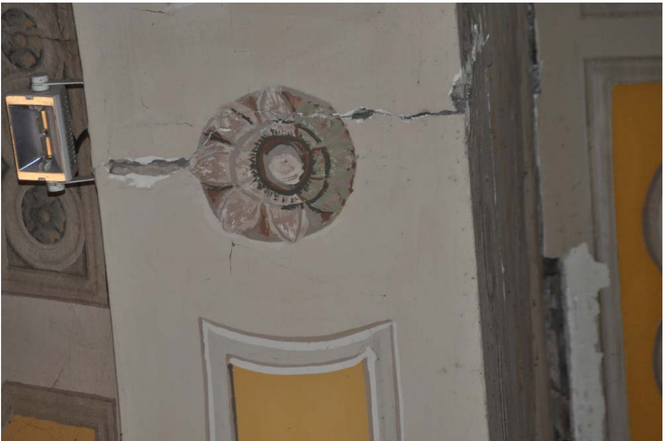
FOTO 16 - dettaglio dell'arco tra abside e transetto
