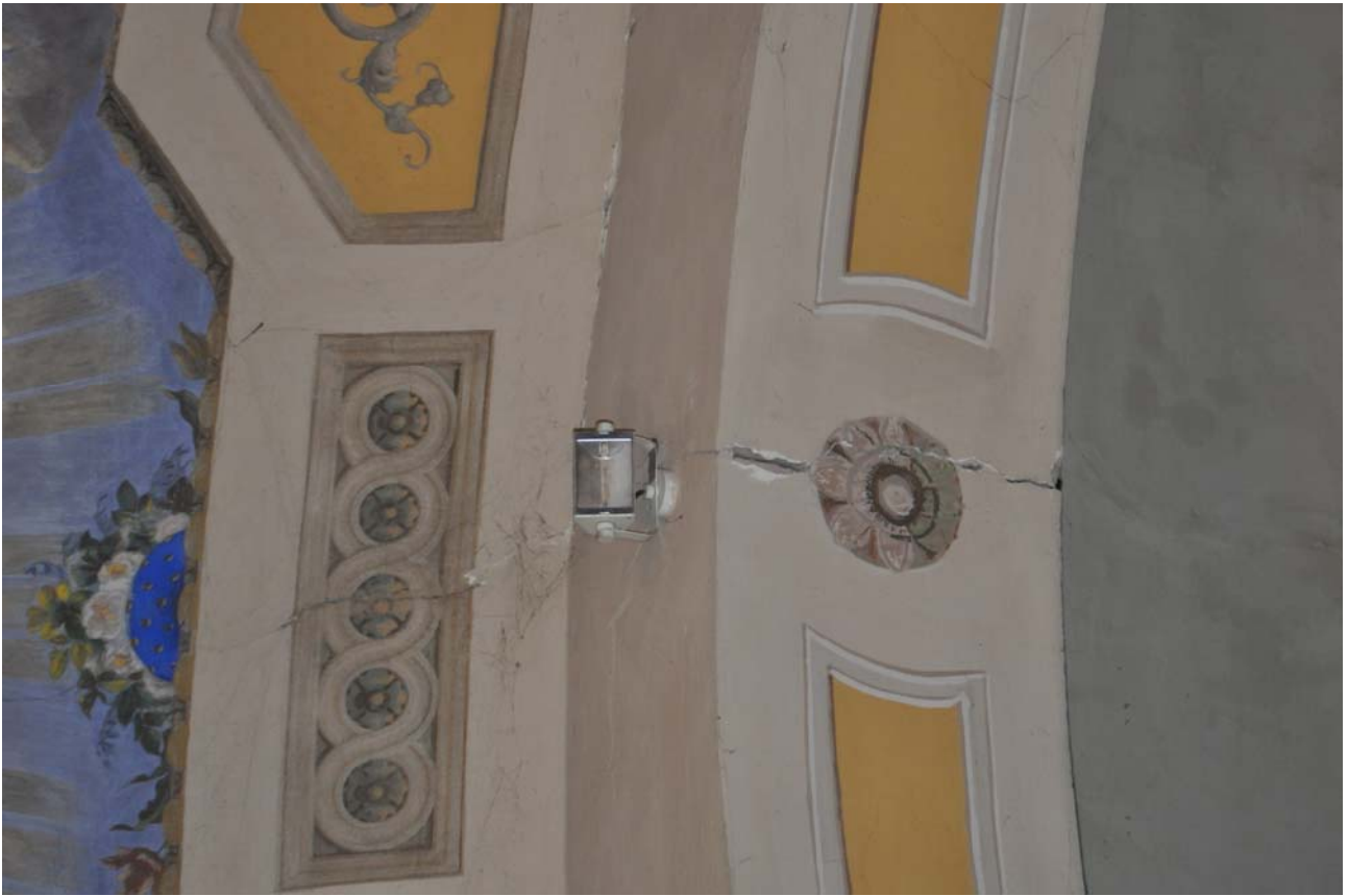
FOTO 15 - dettaglio dell'arco tra abside e transetto
