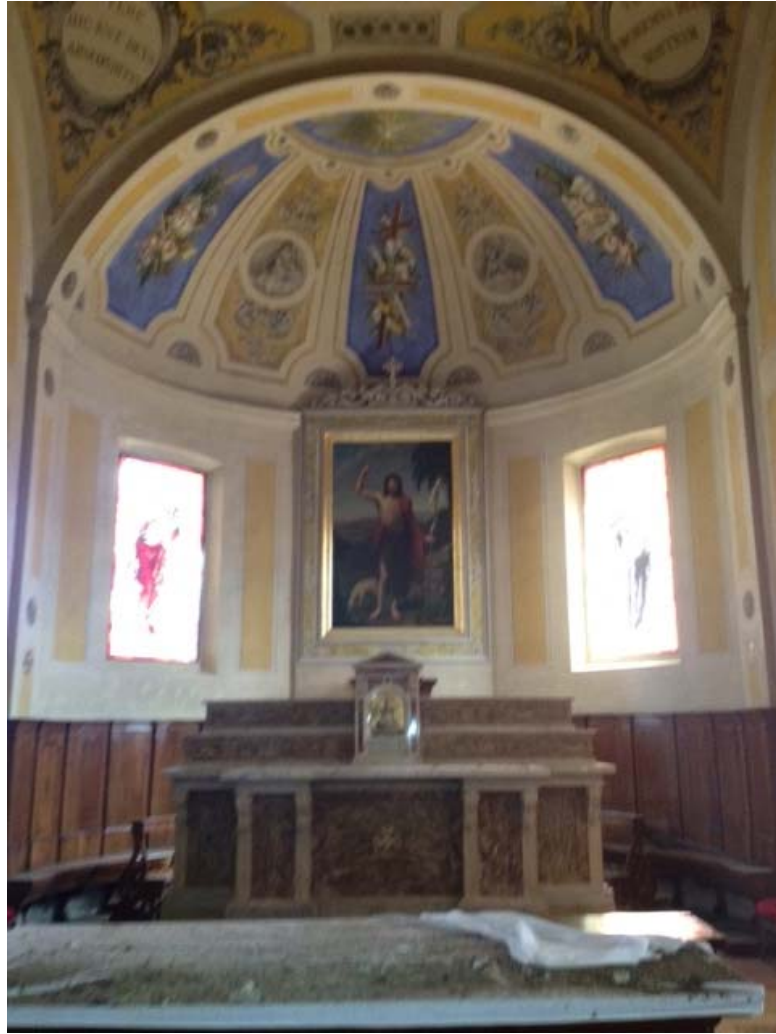
FOTO 13 - vista del catino absidale
