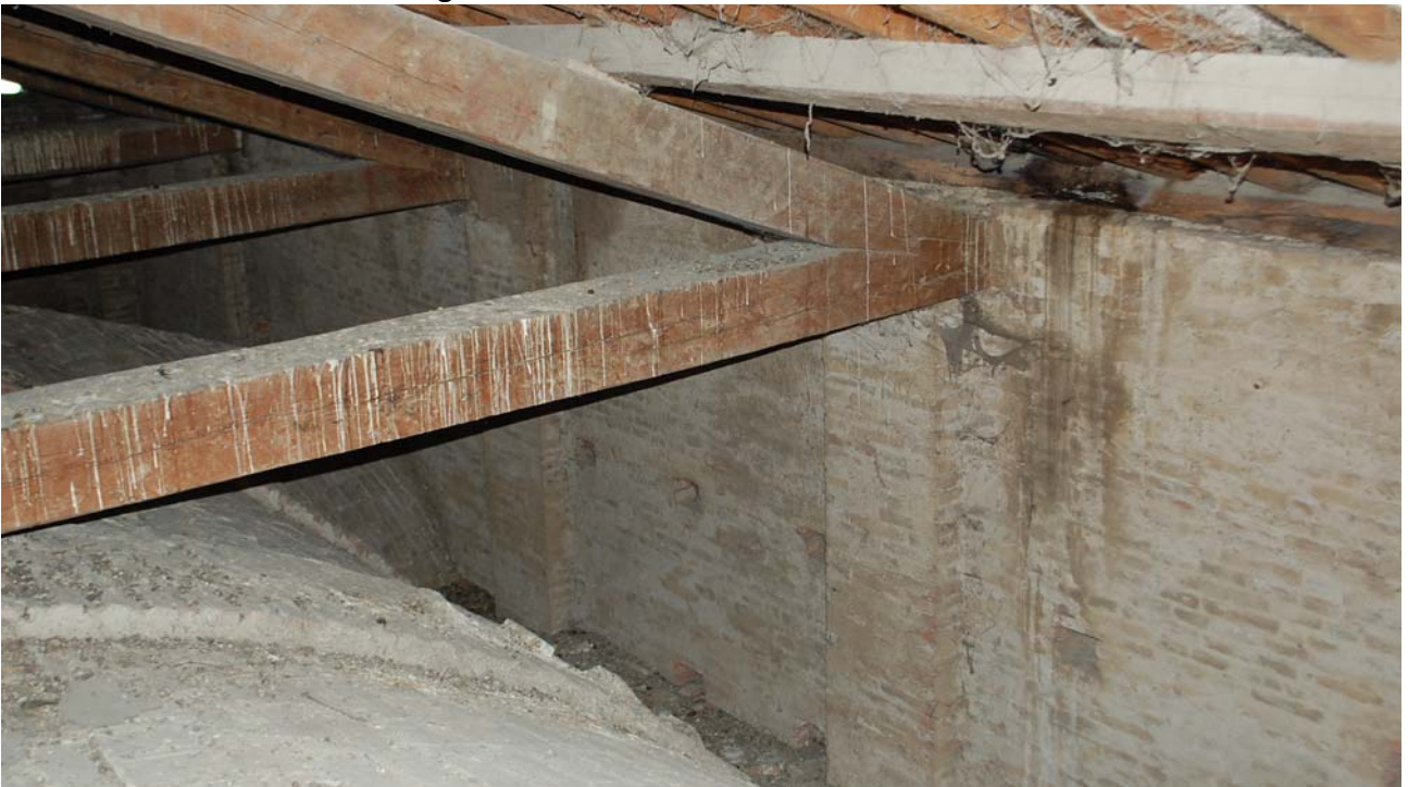
Interno del sottotetto
