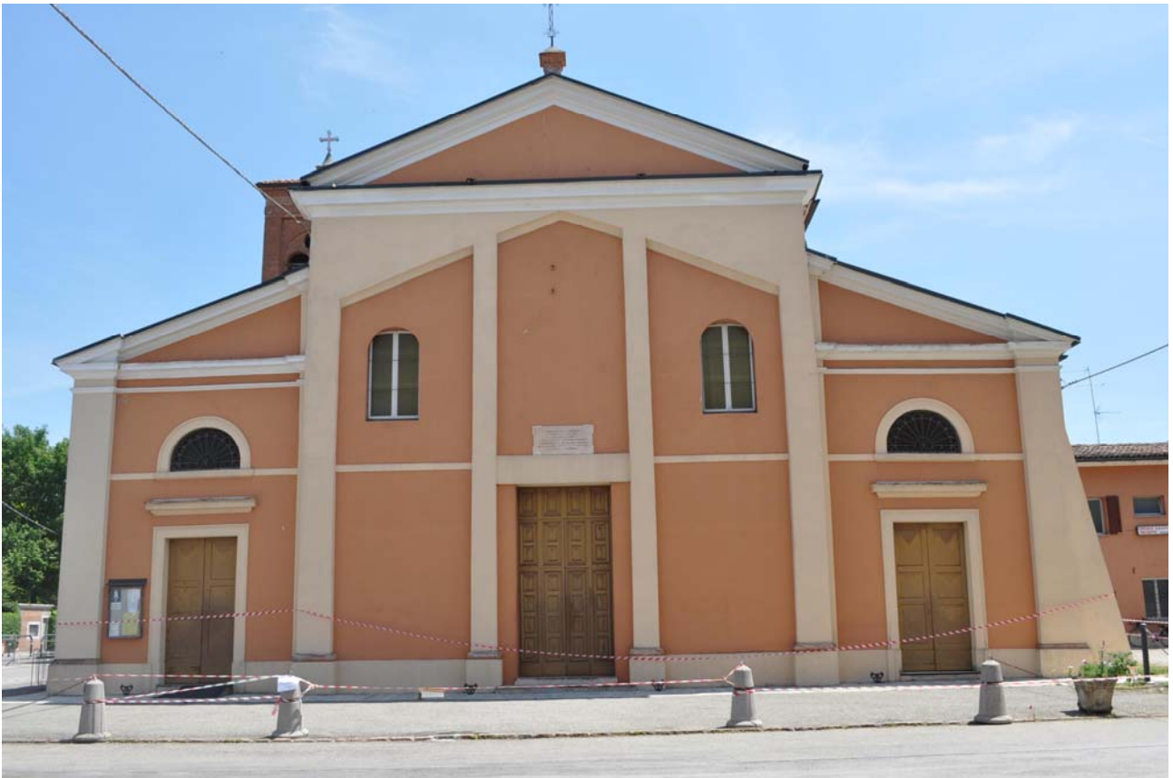
facciata (lato ovest)
