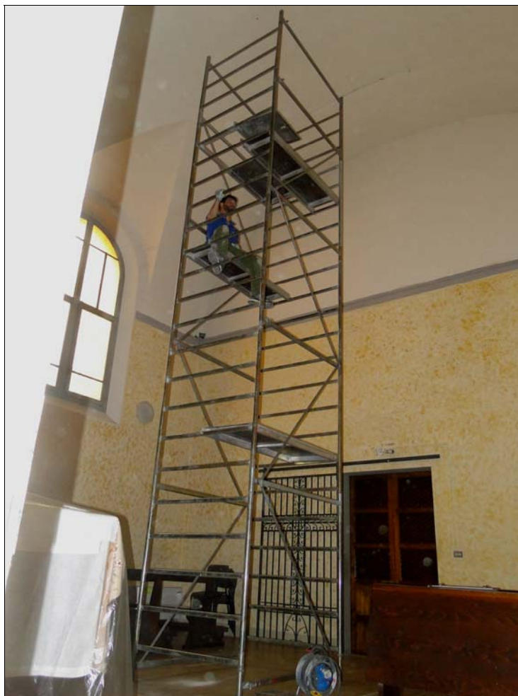
Figura 3.2 – Predisposizione del ponteggio mobile per l'esecuzione dei rilievi in quota
