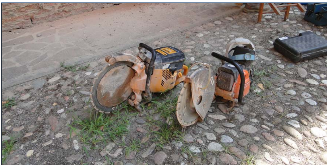
Figura 2.2 – Seghe con motore a scoppio necessarie all'esecuzione dei tagli nella muratura
