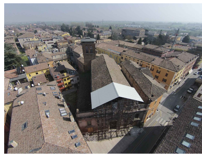
VISTA LATO OVEST
